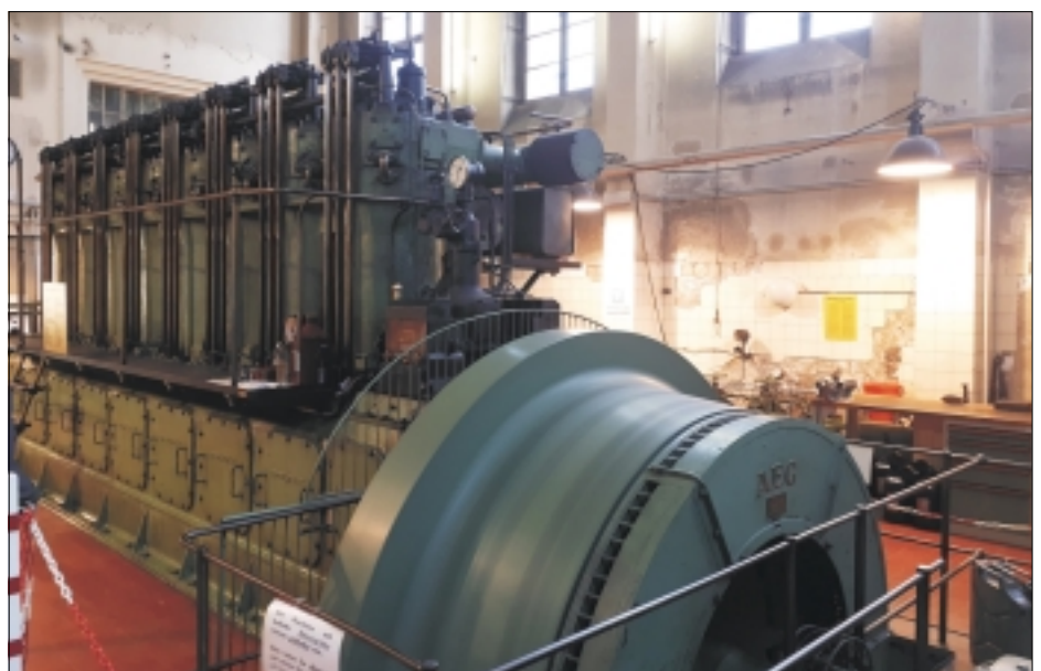
Gewaltig: Der Notstrom-Dieselegenerator.
