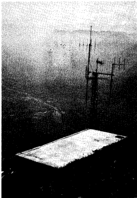
Hauptsendeanlage von Radio Tirol hoch über dem Etschtal auf dem Hochmut. Bild: Schiefele
