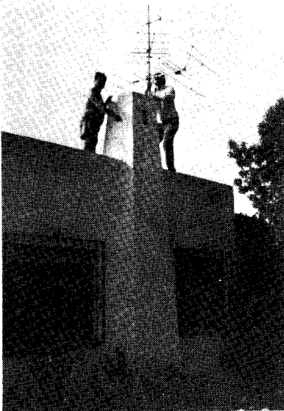
Vater Wiese und Alexander bei der Montage der Antennenanlage
