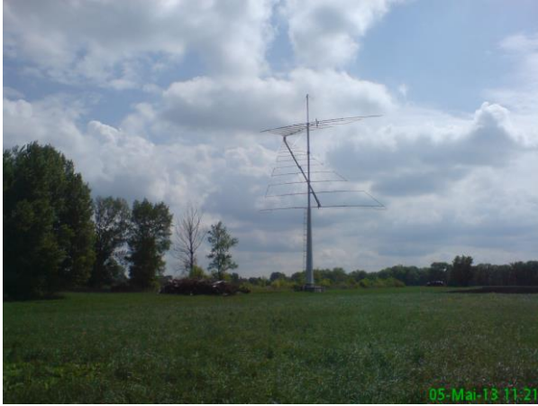
Bild 25: Drehbare logarithmisch-periodische Richtstrahlantenne
