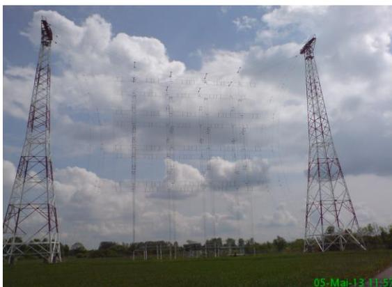
**Bild 22:** Vorhangantenne für Richtstrahlung
