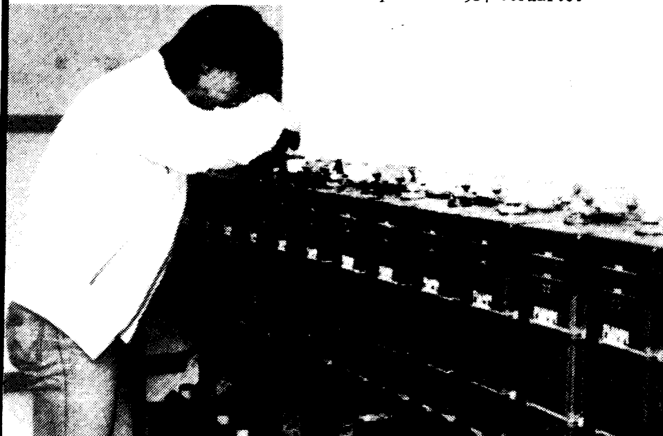
Moderator Axel kontrolliert die Batteriesätze des Notstromaggregats im Keller des Sendehauses von Radio Brenner
