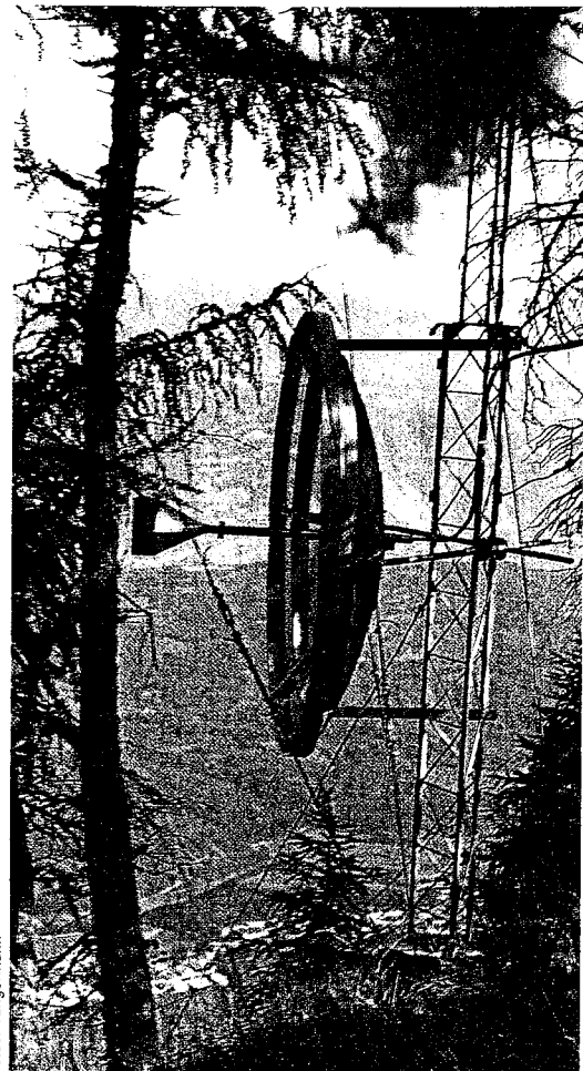
Richtfunkstrecken transportieren das Programm zum eigentlichen Sender. Hier sieht man die Parabolantenne, welche seinerzeit das Radio-C-Programm von Bozen zum Alpengipfel Hühnerspiel transportierte.
