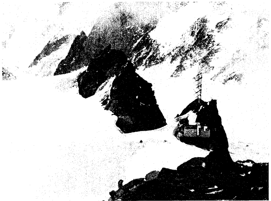
Der Sendercontainer von Radio M 1 auf dem Schwarzenstein enthielt alle Geräte für Radio- und Fernseh-Sendungen – samt Strom-Generatoren und Diesel-Tanks
