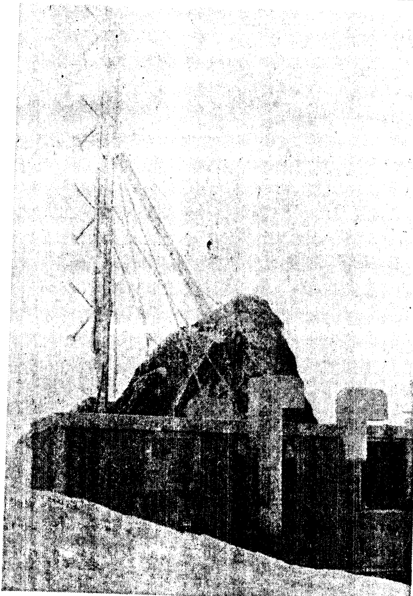
Container und Sendemast am Schwarzenstein. Um sie ist ein regelrechter Kleinkrieg zwischen den Behörden und dem Eigner der Anlagen, dem Bozner Roland Huber, ausgebrochen. Huber scheint plötzlich wieder Vorteile für sich zu verbuchen.
