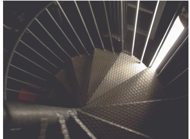
So sieht der Turm im Inneren aus...
